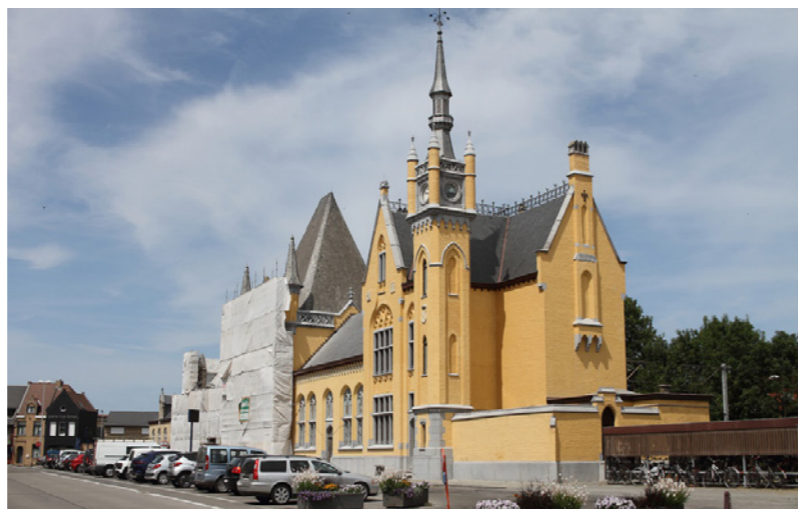
Figuur 23: station Veurne (laatste fase van buitengevelrenovatie (2018))
