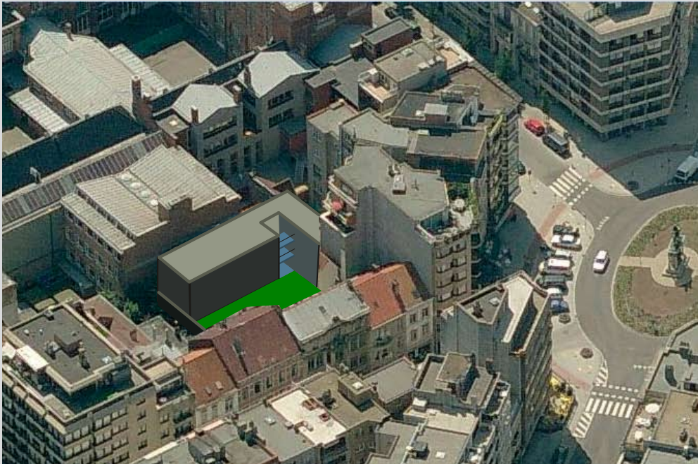
Tegen de hoge perceelsmuren kan gebouwd worden in tweede orde zonder hinder.
