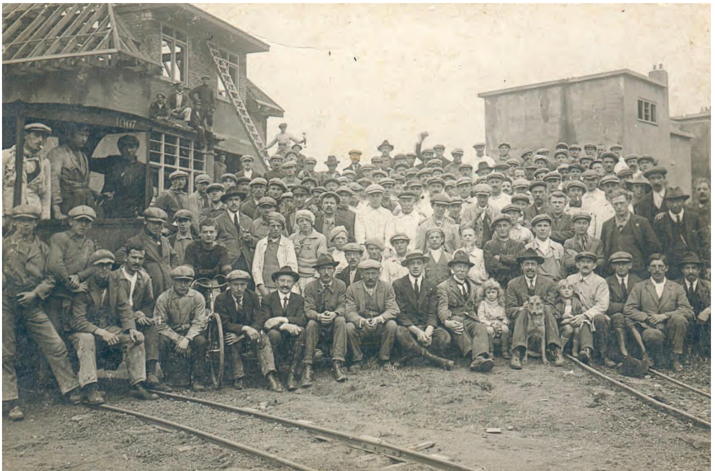
Bouwvakkers en toekomstige bewoners tijdens de bouw van de tuinwijk Kapelleveld in Sint-Lambrechts-Woluwe (1923). Dit woonproject van meer dan 400 woningen werd gerealiseerd door de wooncoöperatie La Cité Jardin du Kapelleveld naar het plan van Louis Van der Swaelmen. Het project bevat bovendien een school, kerk, feestzaal, bibliotheek, sportterreinen, speelpleinen, winkels en een treinstation. Bron: Collectie Jos Kumps.
