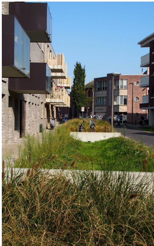
Wadi's (WATERafvoer Door INFILTRatie) zorgen voor een duurzame manier om grondwater opnieuw te infiltreren in de grond - Groen Zuid Hoboken - Stramien
