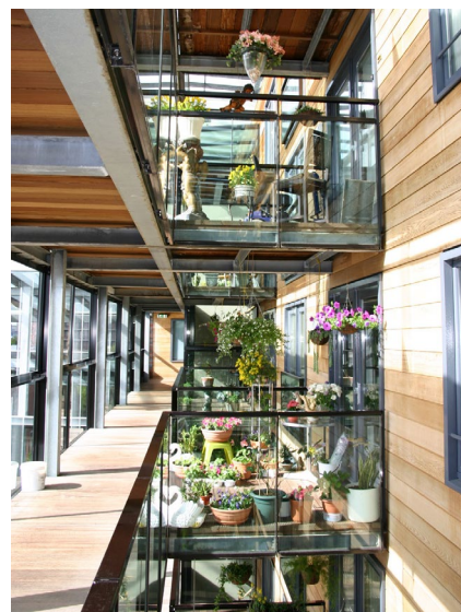
Drempelruimte aan een collectieve passerel vormt een overgang naar de private woningen en kan gebruikt worden als (winter)tuin - Stadstuinen Rotterdam - ©KCAP Architects&Planners
