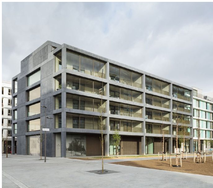
De toevoeging van wintertuinen heeft gezorgd voor een verbetering van de thermische prestaties appartementen. Ze functioneren als thermische buffer die warmte opslaat in de winter en voor schaduw zorgt binnen de woningen in de zomer - Winter Garden Housing Antwerpen - Kempe Thill - © Ulrich Schwarz
