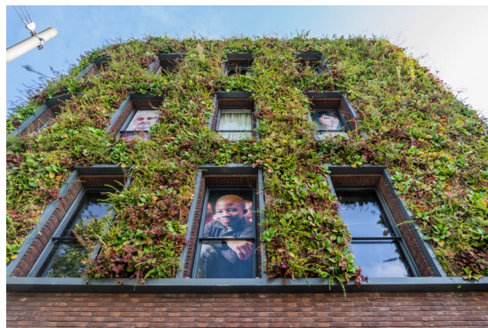
Groene gevel aan de Bibliotheek Permeke in Antwerpen - © STRAMIEN architectuur & ruimte CV
