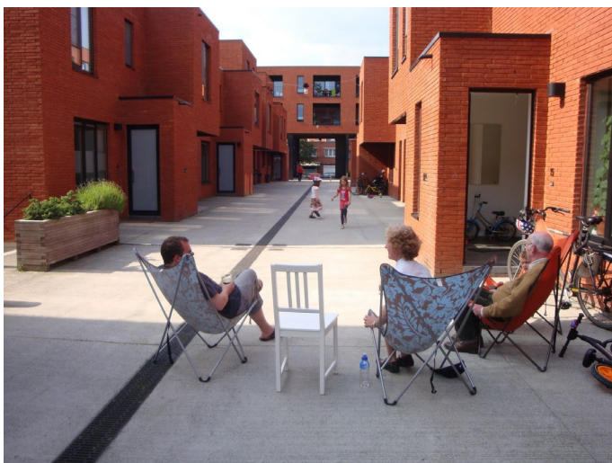
Het minimalistisch design van de autovrije leefstraten laat ruimte voor dagelijks gebruik - Centrale Werkplaatsen Leuven - Bogdan en Van Broeck - © Vectris
