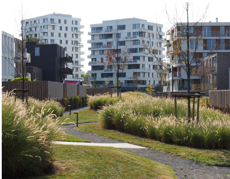
Groene plekken vergroten de belevingswaarde tussen de woningen - Groen Zuid Antwerpen - Binst Architecten
