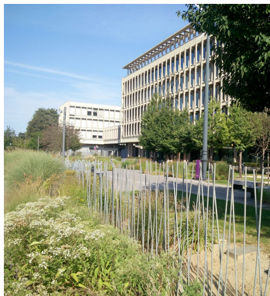
Groen voor belevingswaarde is tegelijk een regentuin voor waterinfiltratie - Sibelga Brussel - AAC Architecture
