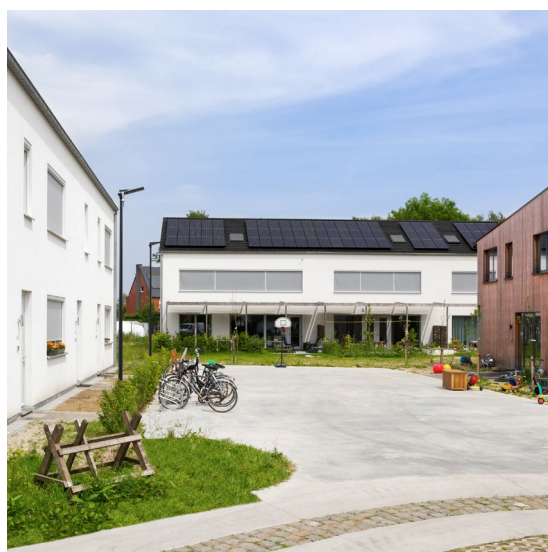
Het autovrije wijkplein vormt het kloppend hart van de cohousinggemeenschap. Hier is plaats om samen te spelen, te eten, te feesten... - cohousing Vinderhoute - Stramien © www.fotolandmark.com
