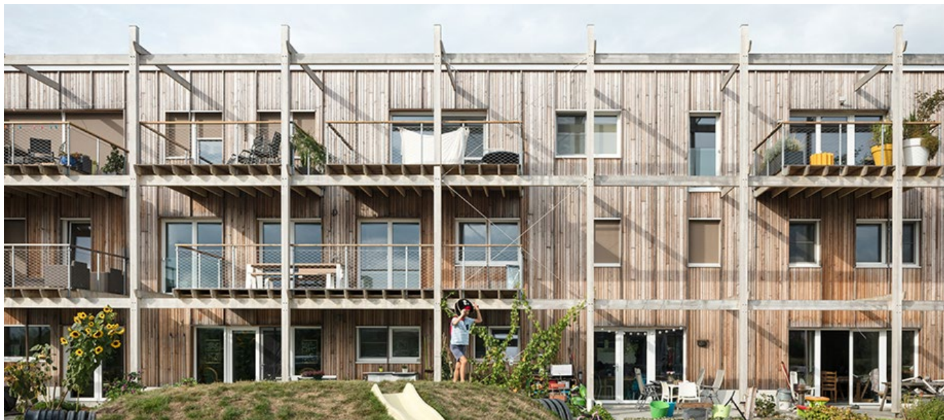
Iedere bewoner mocht, met respect voor materiaal en kleur, een eigen voorkeur qua raamgrootte opgeven. De houten bouwvolumes stralen als een ensemble een dermate sterke identiteit uit, dat het behoorlijk divers wit buitenschrijnwerk pas in tweede instantie wordt opgemerkt - Cohousing Waasland - BLAF Architecten en Denc!-studio - © Stijn Bollaert
