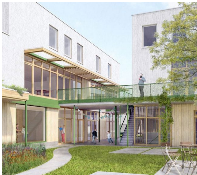
Luifel met afwisselend een open lammellenstructuur en een gesloten balkenstructuur met daarop groen. De luifels beschermen tegen oververhitting in de zomer en markeren de drempel tussen de collectieve tuin en de private buitenruimte - Cohousing Jean Sint-Amandsberg - © ECTV
