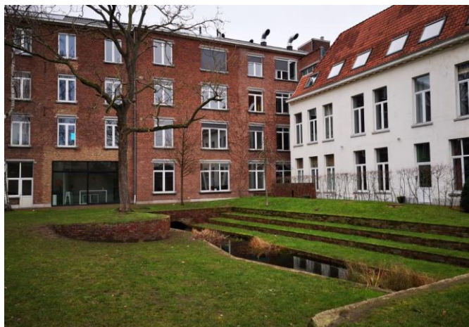
Beeld: Door gesloten bebouwing creëer je een geluidsluwe plek in het binnenblok, TuinOH! In Mechelen (© Gilke Pée)
