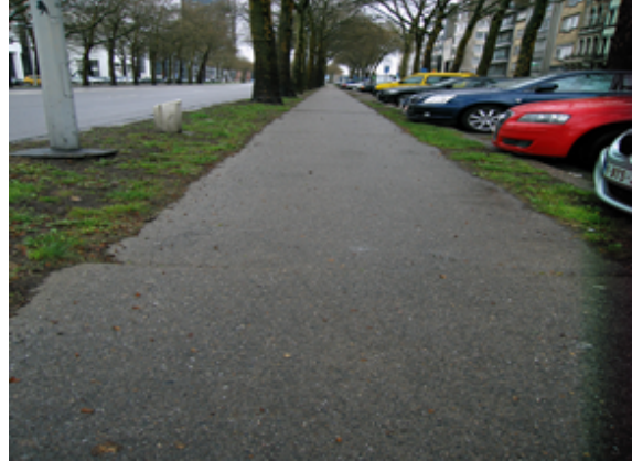
Fietspad in platenbeton
