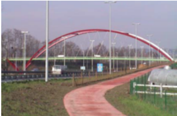
Fietspad in doorgaand gewapend beton
