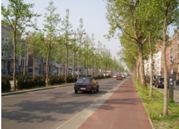
Fietspad in asfalt
