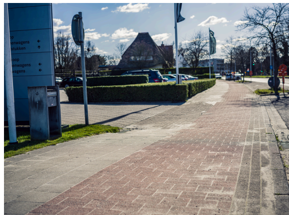
Fietspad in kleinschalige elementen
