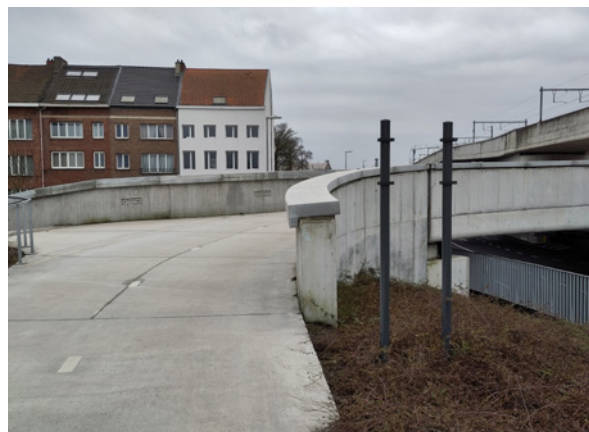
Figuur 7: Zichtlijnen in een bocht: ononderbroken zichtlijnen (links: Krugerbrug Antwerpen) en onderbroken zichtlijnen (rechts: tangentsknoop Mechelen). Bron: MINT
