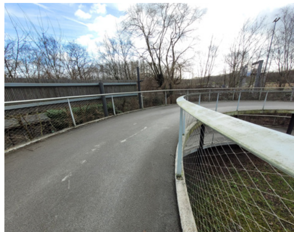
Figuur 29: Schuwafstand als deel van de afwerking van het talud van de brug (links: fietsbrug Kuringen, Hasselt, lage complexiteit) vs. geen visueel aangegeven schuwafstand (rechts: Zoë Borluutbrug Gent, hoge complexiteit). Bron: MINT
