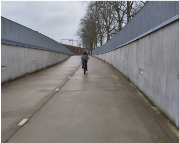
Figuur 20: Bredere helling (links: 5 m; Jubellaan Mechelen, lage complexiteit) en minder brede helling (rechts: 3 m; Collegebrug Kortrijk, hoge complexiteit). De vormgeving van de wanden (gesloten of open) heeft een sterke invloed op hoe de breedte gepercipieerd wordt. Bron: MINT
