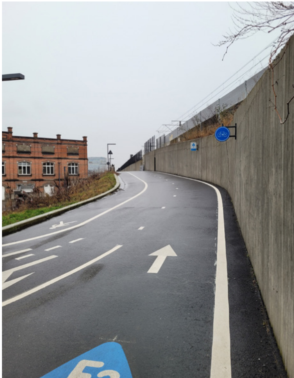
Figuur 28: Schuwafstand aanwezig door belijning (links: Ringbrug Zaventem, lage complexiteit) of door schuine wand (rechts: Malinas Mechelen, lage complexiteit). Bron: MINT
