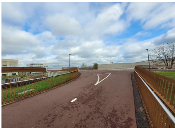
Figuur 7: Zichtlijnen in een bocht: ononderbroken zichtlijnen (links: Krugerbrug Antwerpen) en onderbroken zichtlijnen (rechts: tangentsknoop Mechelen). Bron: MINT
