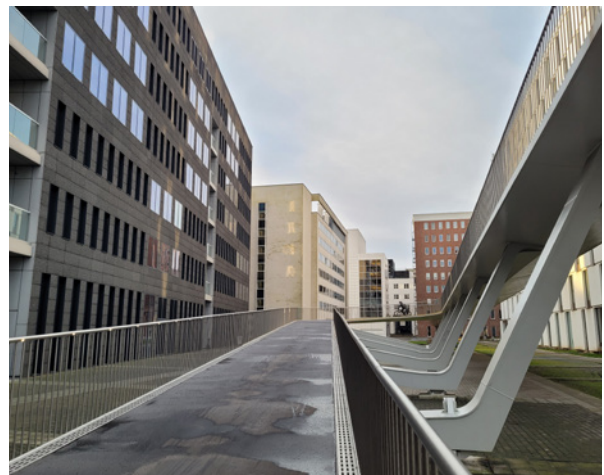
Figuur 27: Helling met plateau (links: fietsbrug Kuringen, Hasselt, lage complexiteit) en helling zonder plateau (rechts: Parkbrug Antwerpen, hoge complexiteit). Bron: MINT
