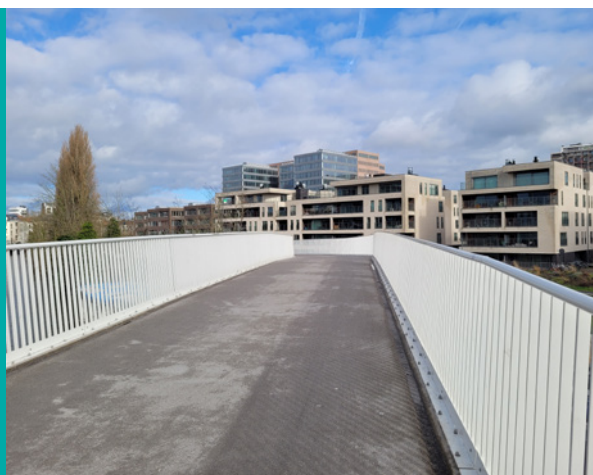
Figuur 23: (On)doorzichtige leuning afhankelijk van het perspectief Louisa d'Havébrug Gent. Bron: MINT
