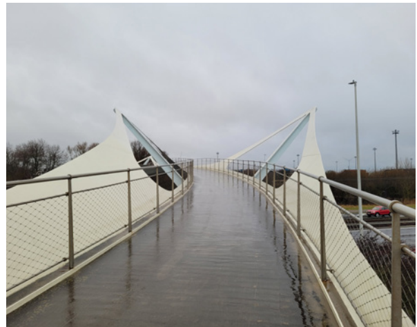
Figuur 18: Minder steile helling (links: 2%; Malinas Mechelen, lage complexiteit) en steilere helling (rechts: 3,7% - 5,4%; De Lichtenlijn Knokke-Heist, hogere complexiteit). Bron: MINT
