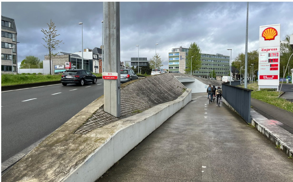
Figuur 4: Hoogteverschil minimaliseren door een gedifferentieerde helling voor fietsers (onder: De Sterre Gent waar de rijweg verhoogd werd om het hoogteverschil voor fietsers te beperken, rechtsboven: Schijnpoortweg Antwerpen waar het fietspad minder laag zakt de rijweg, omdat het minder vrije hoogte nodig heeft). Bron: MINT
