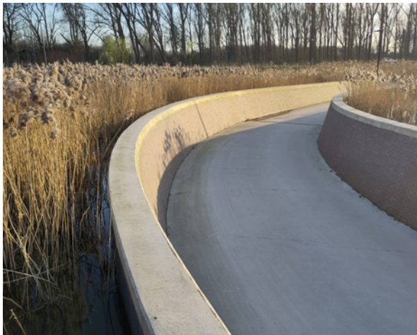
Figuur 18: Minder steile helling (links: 2%; Malinas Mechelen, lage complexiteit) en steilere helling (rechts: 3,7% - 5,4%; De Lichtenlijn Knokke-Heist, hogere complexiteit). Bron: MINT
