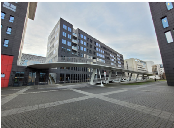
Figuur 32: Obstakelvrije aan-/uitloop (links: Parkbrug Antwerpen, lage complexiteit) vs. aan-/uitloop met obstakels (rechts: Ringbrug Zaventem, hoge complexiteit). Bron: MINT
