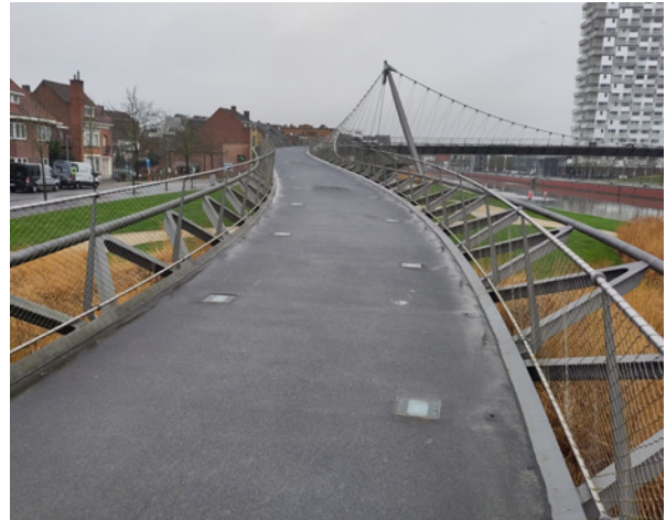
Figuur 20: Bredere helling (links: 5 m; Jubellaan Mechelen, lage complexiteit) en minder brede helling (rechts: 3 m; Collegebrug Kortrijk, hoge complexiteit). De vormgeving van de wanden (gesloten of open) heeft een sterke invloed op hoe de breedte gepercipieerd wordt. Bron: MINT
