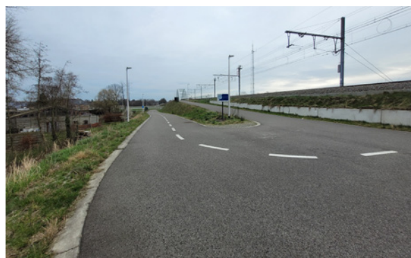
Figuur 36: Compensatievoorbeeld fietsbrug Kuringen, Hasselt: een groot hoogteverschil op een helling op de volle grond: geen leuning, open zichtlijnen, een verbrede bocht, complexe aanloop (paaltjes, T-aansluiting) waar met markeringen wordt gewerkt aan een lagere complexiteit. Bron: MINT
