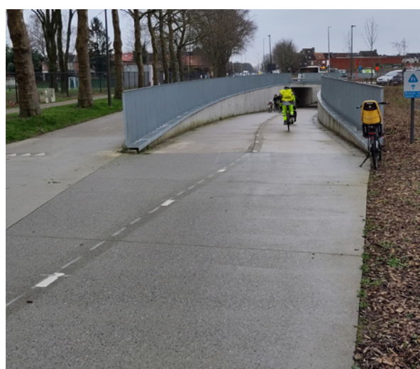
Figuur 10: Aansluiting maaiveld - doortrekking fietssnelweg en zijtak uit de voorrang: markeringen en materialisatie verlagen de complexiteit - Jubellaan Mechelen. Bron: MINT
