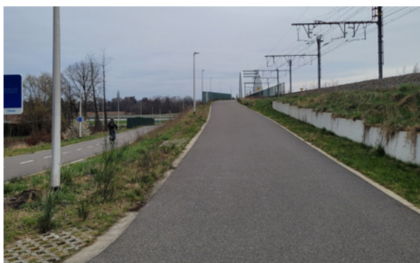
Figuur 36: Compensatievoorbeeld fietsbrug Kuringen, Hasselt: een groot hoogteverschil op een helling op de volle grond: geen leuning, open zichtlijnen, een verbrede bocht, complexe aanloop (paaltjes, T-aansluiting) waar met markeringen wordt gewerkt aan een lagere complexiteit. Bron: MINT
