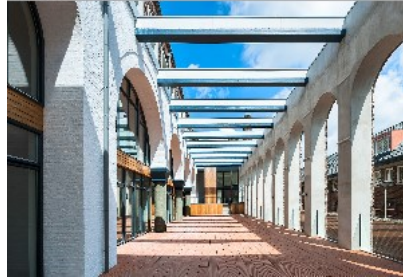
WOONZORGGEBOUW GROVESTINSTRAAT MOERWIJK
