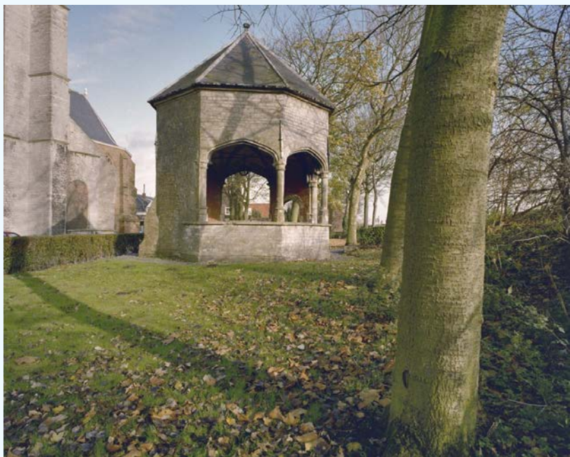
De cisterne bij de Grote Kerk van Veere wordt gevoed met regenwater van het kerkdak.
