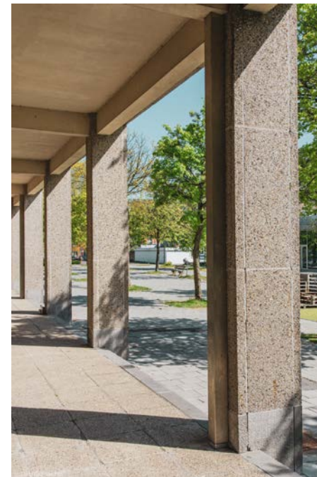
Sommige regenpijpen lopen langs de 'binnenkant' van de zuil.
