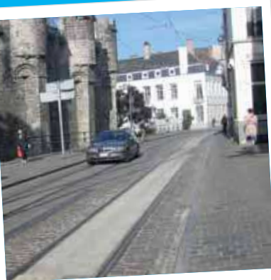
Meer fietscomfort: betonstrook in de Geldmunt
