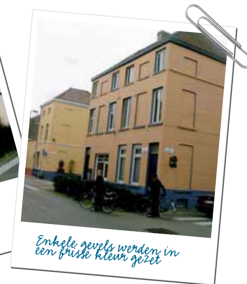
Het Duurzaam Huis startte, ism met de Stad, een bouwblokrenovatie in de buurt rond het Banierparkje
