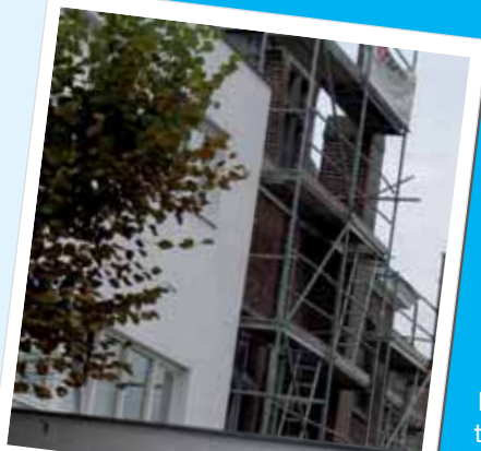
Renovatie van het dienstencentrum van Oostakker
