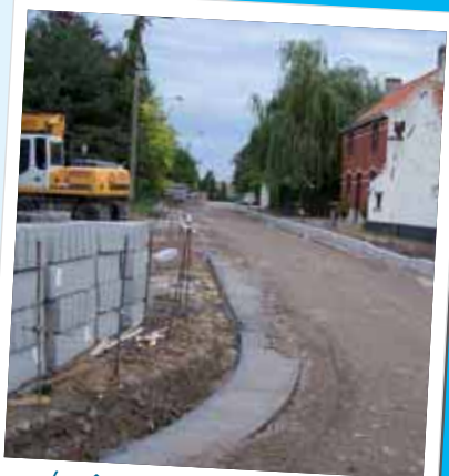
In Sint-Denijs-Westrem en Afsnee zijn belangrijke rioleringswerken aan de gang.
