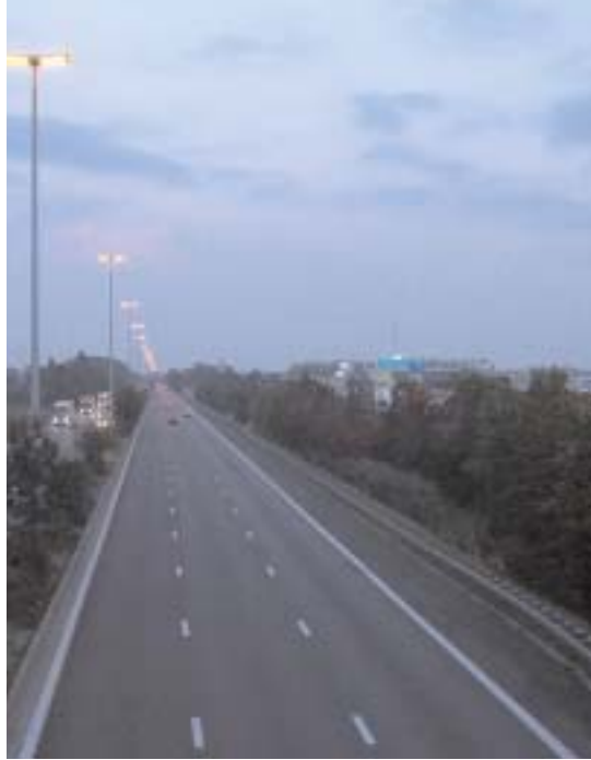
Het bedrijventerrein aan de E40 wordt heringericht
